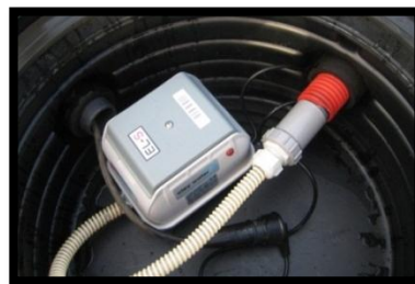
Figure 7-11: Raccordement électrique en local technique pour les Oxyfix 9EH et 11EH
